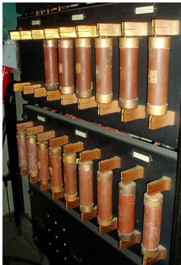
Utseendet på säkringarna är väldigt avvikande jämfört med dagens proppsäkringar. Det är ett slags knivsäckringar med säkringshållarna placerade i högspänningsskammaren.
