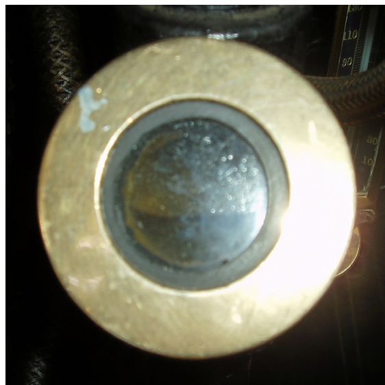
På alternatorn kan man i synglasen kontrollera att vattenkylningen fungerar som den ska.
