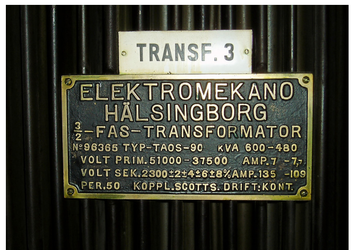
Märkplåt för 3-fas/2-fas transformator
