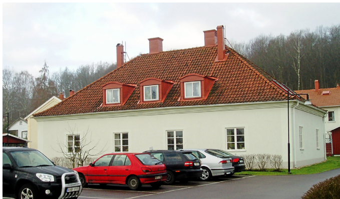
Stationsbyggnaden i Kungsbacka är byggd i nyklassik stil, samma som i Grimeton. I dag innehåller byggnaden två lägenheter om är privatbostäder.
