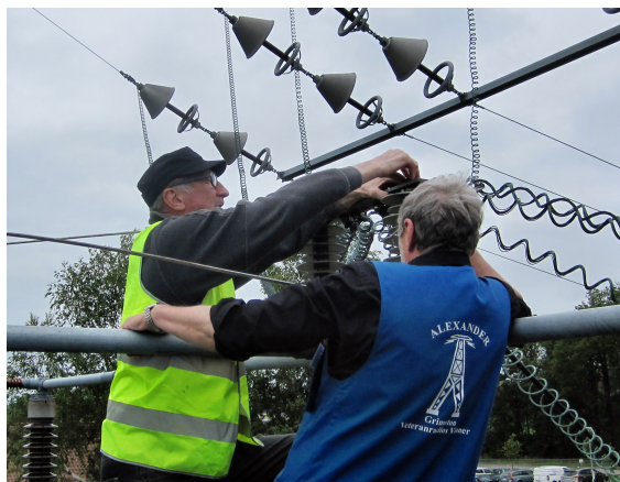
Mats och Jan åtgärdar isolatorn
